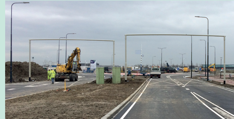
Op deze locatie wordt gebouwd aan de nieuwe, veilige spoorwegovergang.
